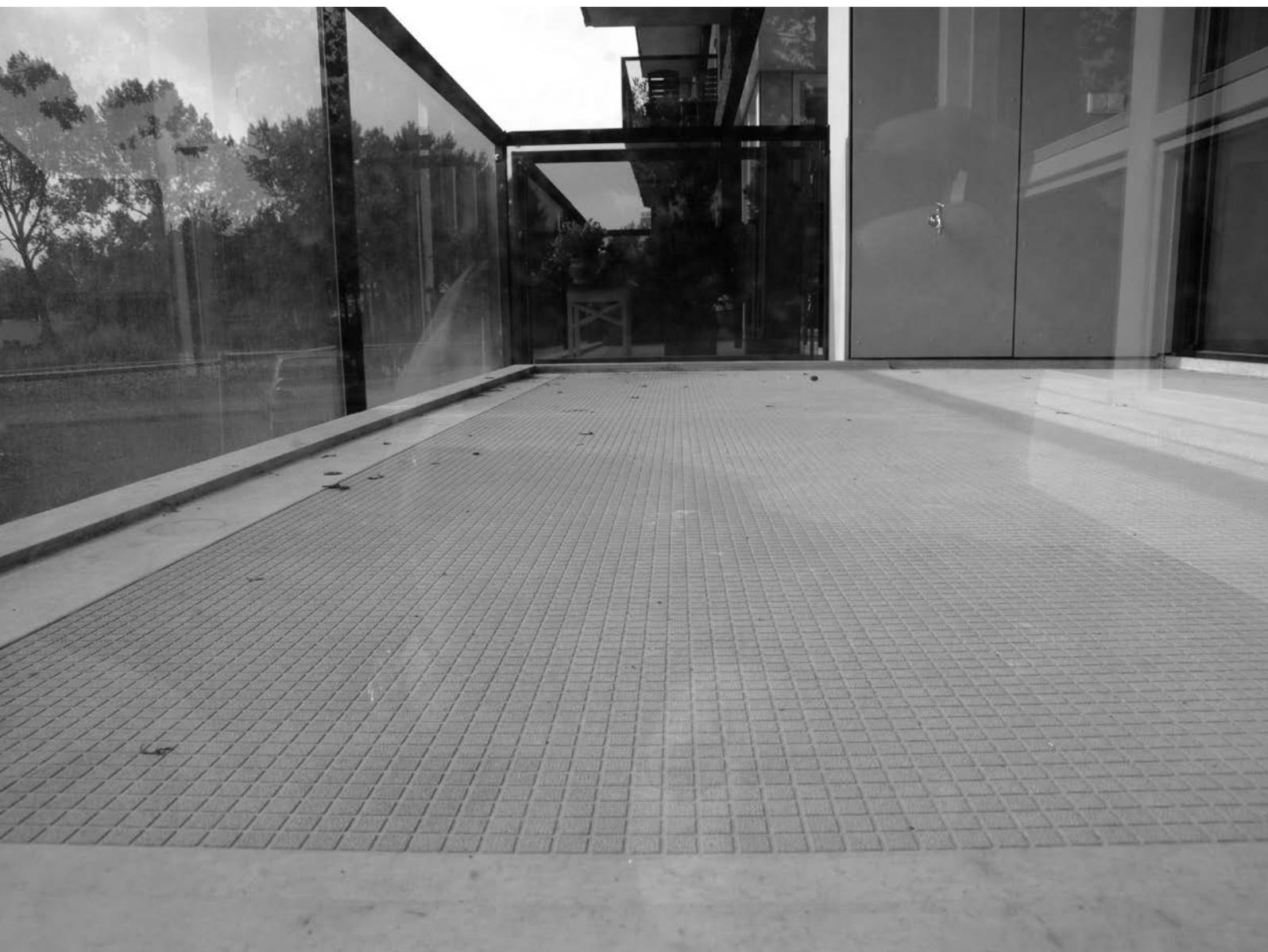
Бетонные элементы без швов с рисунком протектора. Большая длина и большая ширина текстурных матов **GIAN** позволяют создавать практически бесшовные рисунки на поверхности бетона.
