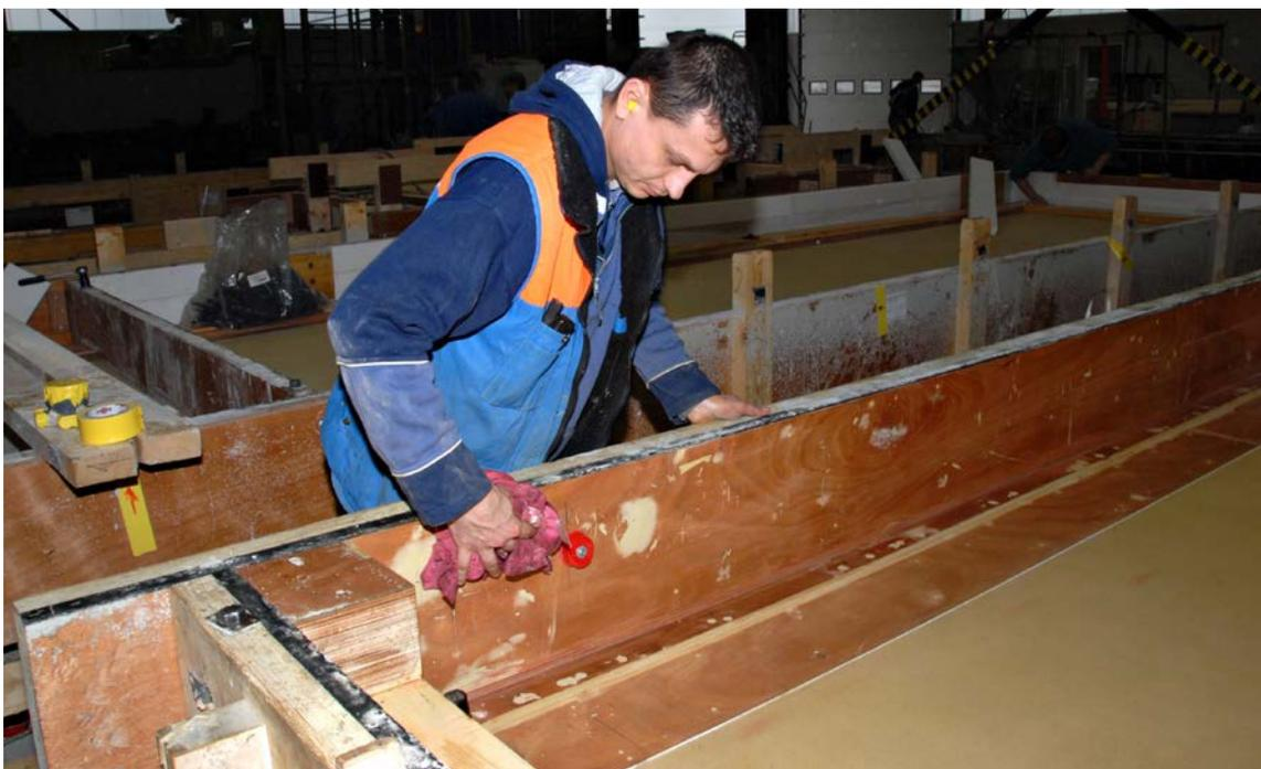
Форма очищается перед следующей заливкой бетона.
